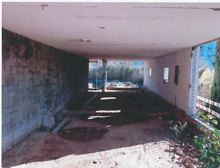
Fig. 4 – Vista do interior do edifício nº 12 da Rua Teixeira de Pascoais
